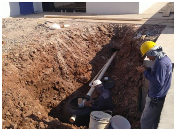
Figura 4.67: Sistema de tratamento de efluentes instalado na casa de força. Fonte: C-nível, 2023.
