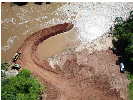
Figura 17.13: Sobrevoio de drone da construção da ensecadeira na casa de força. Fonte: C-nível, 2021.
