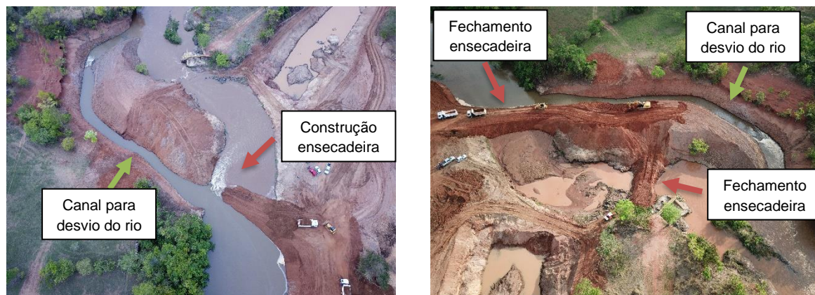
Figura 17.8: Canal para desvio do rio e construção da ensecadeira. Fonte: C-nível, 2021.
