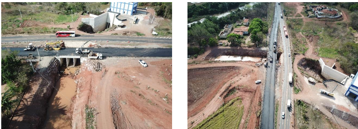
Figura 4.25: Construção da galeria para transposição do canal e desvio do trânsito - 4º Relatório. Fonte: C-nível, 2023.
