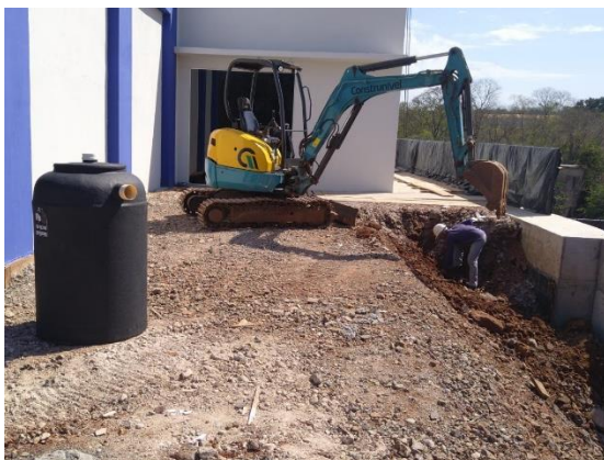
Figura 4.67: Sistema de tratamento de efluentes instalado na casa de força. Fonte: C-nível, 2023.
