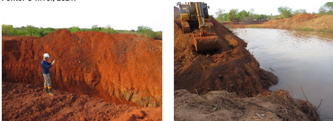
Figura 17.9: Movimentações do solo para estreitamento da calha do rio e construção da ensecadeira. Fonte: C-nível, 2021.
