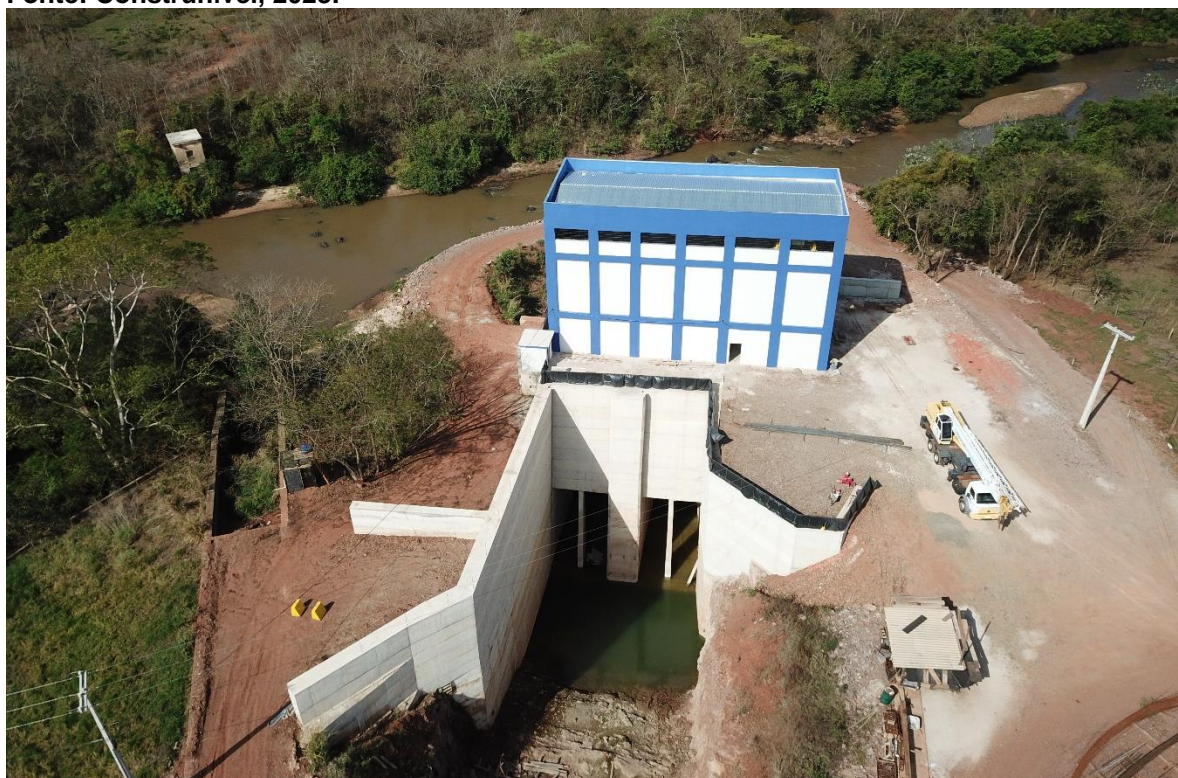
Figura 3.4: Visão aérea da casa de força e câmara de carga da CGH Mimosa. Fonte: Construnível, 2023.
